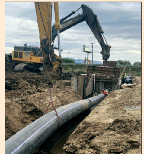
La tubería de suministro de agua de College Lake se colocó debajo de la autopista 1, el 15 de Noviembre del 2023
